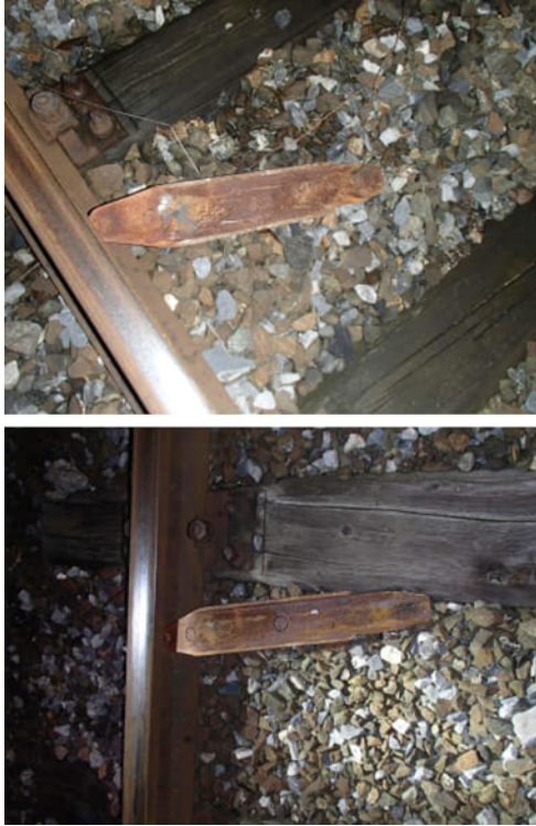
Abbildung 4 Hemmschuhe Bf Lb in km 33,454 sowie in km 33,416
