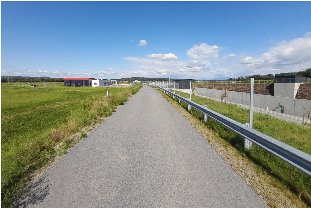
Abbildung 1, Fluchtstiegenhauszufahrt, Blickrichtung Kreisverkehr (ASt B57a)
