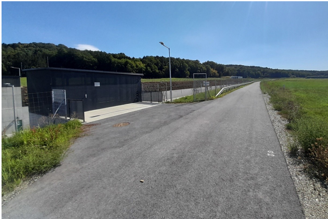
Abbildung 2, Fluchtstiegenhaus und Zufahrt, Blickrichtung Westportal Tunnel Rudersdorf
