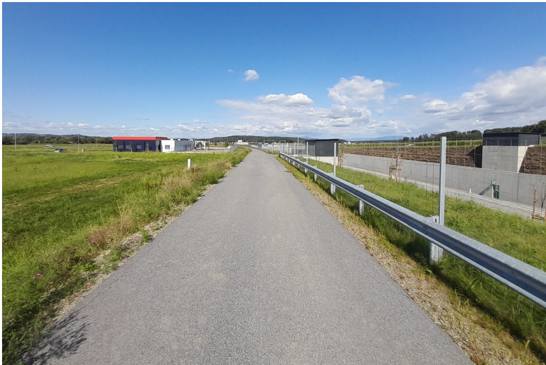
Abbildung 1, Fluchstiegenhauszufahrt, Blickrichtung Kreisverkehr (ASt B57a)
