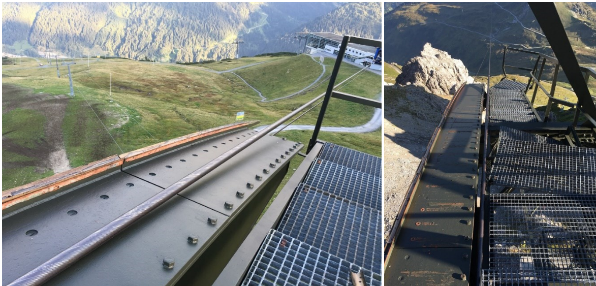
Abbildung 3: Tragseil TII/2 der Personenseilbahn „Vallugabahn, I. Teilstrecke“ im Auflagebereich der Stütze 1 (linkes Bild mit Talstation) und im Auflagebereich der Stütze 2 (rechtes Bild)
