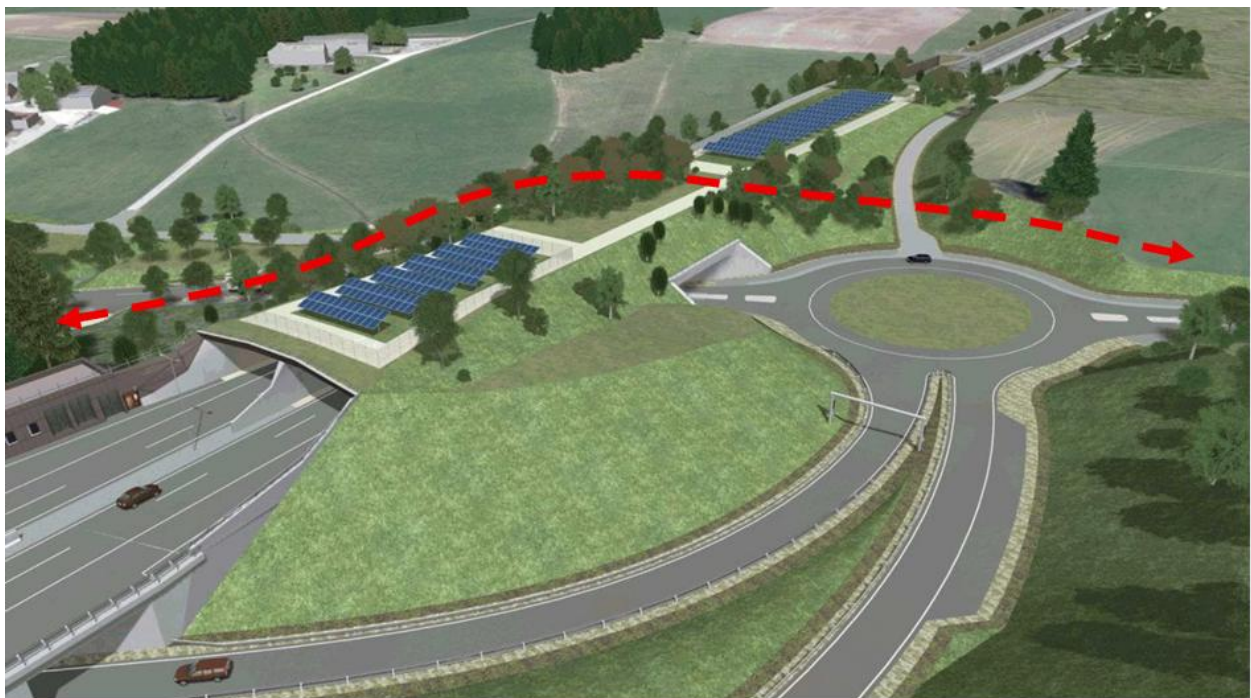
Abbildung 6: Einhausung Rainbach – geplante PV-Anlage mit Leitpflanzungen und eingetragendem Flugkorridor (Quelle: EZ 5 Visualisierungen Photovoltaikanlage Einhausung Rainbach, bearbeitet).
